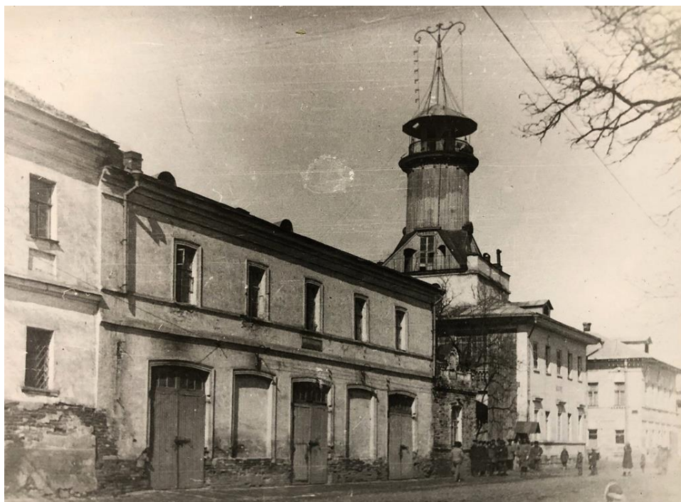
Рис. 4. Вид на бывшие здания пожарной части 2-го участка и часть Индийского торгового подворья слева. Фотография 1950-х гг. Из частной коллекции С. Ю. Степанова
