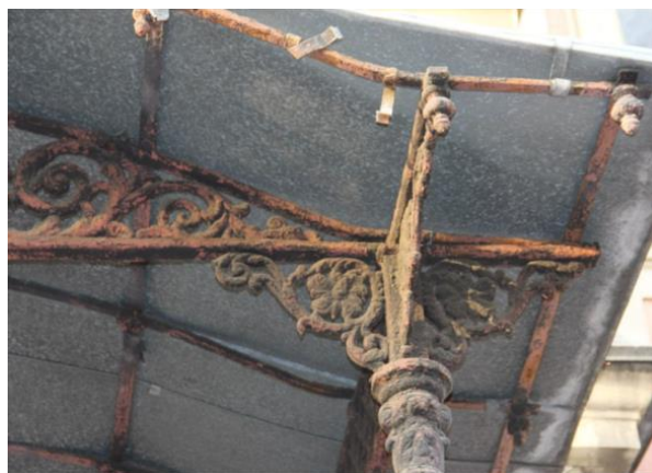
Рис. 12. Кронштейны столбов. Узел перехода обвязки в колонну. Фото 2018 г. (материалы ООО «Северо-Западное проектное бюро»)
