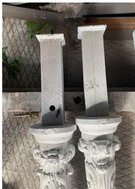
Рис. 6. Верхние выпуски литых колонн. Фотография Ю. А. Горелик, 2022 г.
