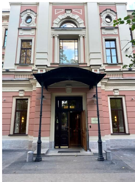
Рис. 14. Установленный после реставрации козырек. Фотография Ю. А. Горелик, 2023 г.
