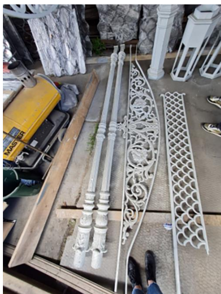
Рис. 7. Колонны, центральный тимпан и боковые части козырька. Фотография Ю. А. Горелик, 2022 г.
