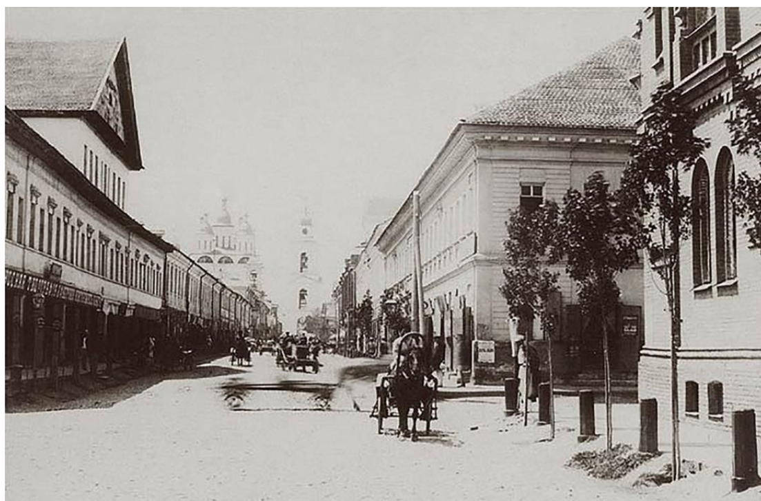
Рис. 3. Вид ул. Екатерининской в Астрахани. Фотография конца XIX в. (слева – двухэтажное здание под черепичной крышей – утраченный дом Могундаса Теридасова). Из частной коллекции С. Ю. Степанова
