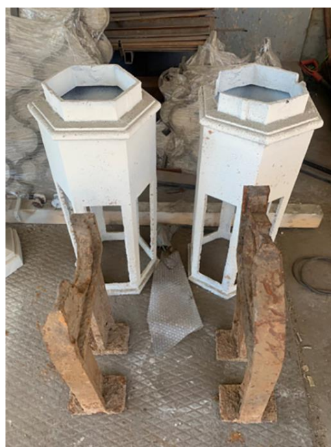
Рис. 2. Подземная часть чугунных литых столбов козырька богадельни в мастерской. Фотография Ю. А. Горелик, 2022 г.
