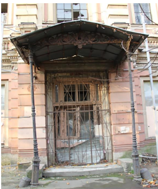
Рис. 1. Конструкция исследуемого козырька до производства работ. Фотография 2018 г. (материалы ООО «Северо-Западное проектное бюро»)
