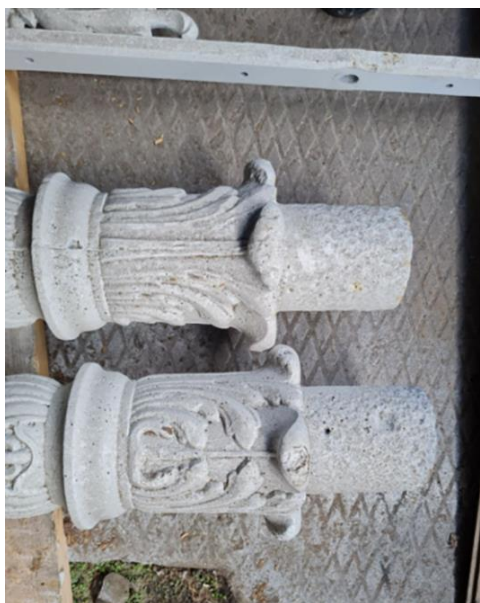
Рис. 5. Нижние выпуски литых колонн. Фотография Ю. А. Горелик, 2022 г.
