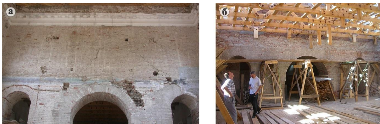
Рис. 5. Восстановленные конструкции здания мечети:
