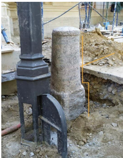
Рис. 13. Установка фундамента опоры столба. Фотография Ю. А. Горелик, 2023 г.
