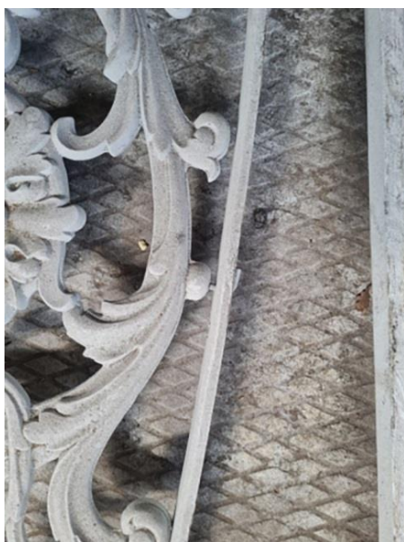
Рис. 9. Крепление направляющей и литого элемента центрального тимпана. Фотография Ю. А. Горелик, 2022 г.
