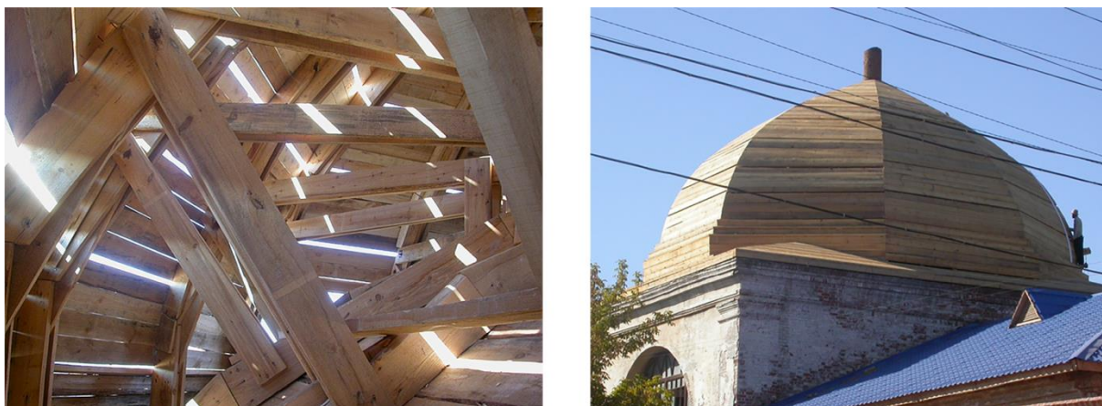
Рис. 7. Конструкции наружного купола
