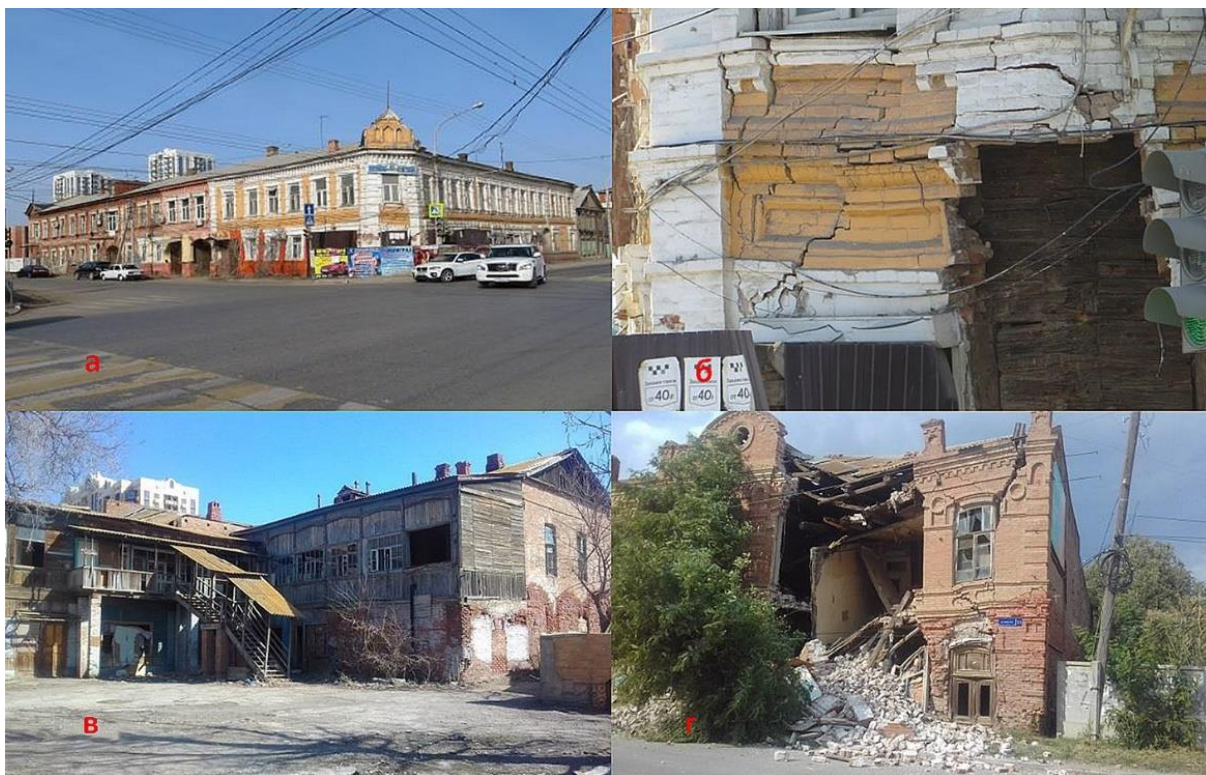
Рис. 3. Примеры деградации исторической среды: а, б) разрушающийся памятник архитектуры на ул. Бакинская, 25; в) вид на дом М. Г. Розенблюм со стороны двора; г) обрушение здания вследствие подтопления и засоления (в настоящее время дом снесен полностью). Фотографии Ю. С. Чуйкова [13, с. 93]
