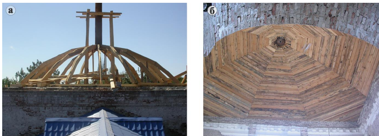
Рис. 6. Конструкции внутреннего купола гумбаза:
